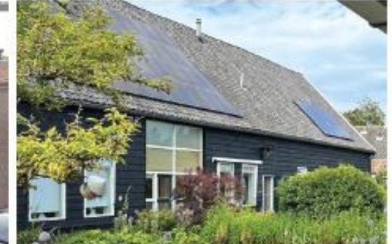
0.5% houtschuur (zwart geverfd hout, met witte kozijnen, donker-groene deur, rood pannendak)
